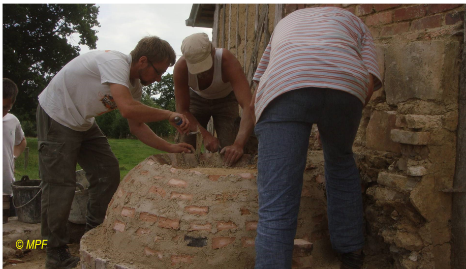
Reconstruction d'un four à pain
